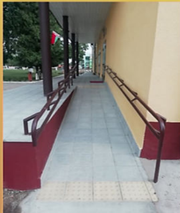
Укладка тактильной плитки и понижение бордюрного камня на тротуарах
