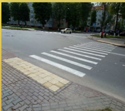
Установка пандуса, укладка тактильной плитки
